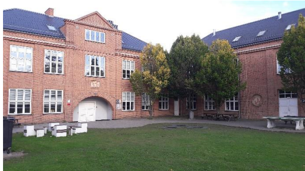
FIGUR 5. FACADE AF CASE-STUDIE BYGNINGEN
